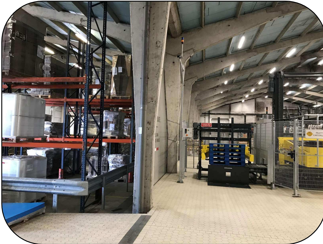
Point de vue depuis l'opposé du bâtiment. Le palettiseur, qui est le seul équipement présent dans la bande des 10 m, est visible sur la droite.
